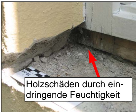
Abbildung 10: Ansicht der Brüstung nach Rückbau der Fensterbank.
