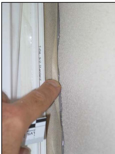
Abbildung 14 : Beispielhaft dargestellte fachgerechte Fugenabdichtungen.
