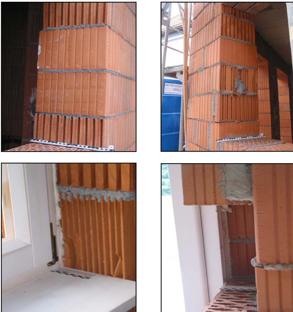
Abbildung 11 : Mangelhaft vorbereitete Leibungsflächen.
