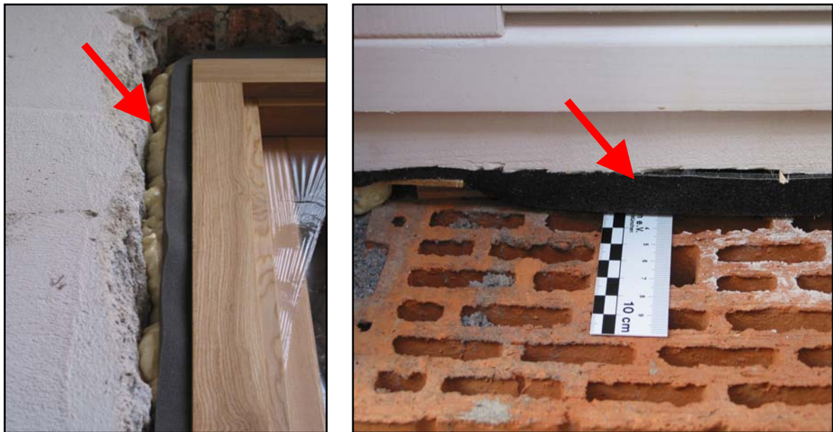
Abbildung 4 : Ungeeigneter Einsatz eines vorkomprimierten Fugendichtbandes.
