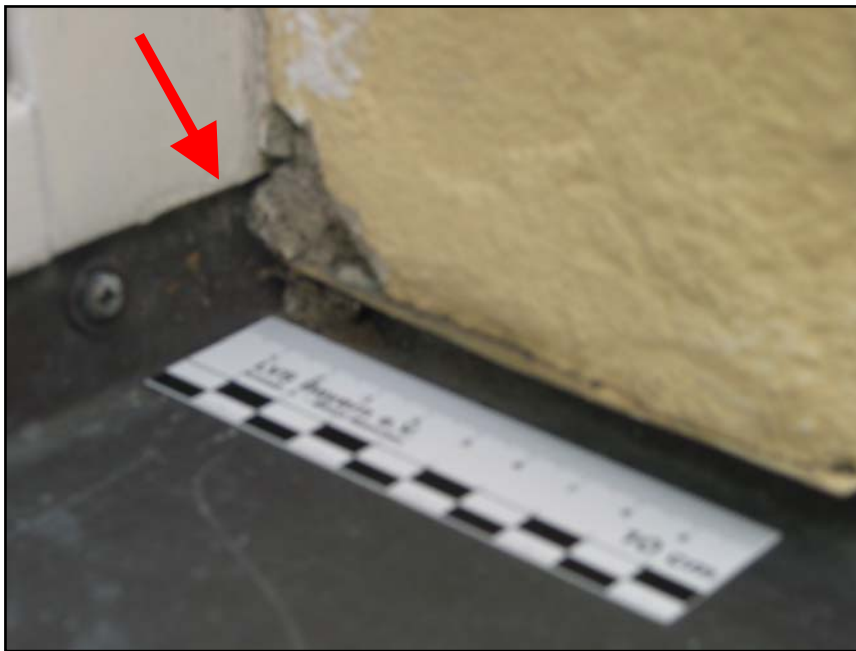
Abbildung 9: Nahaufnahme des Fensterbankanschlusses an den äußeren Blendrahmen.
