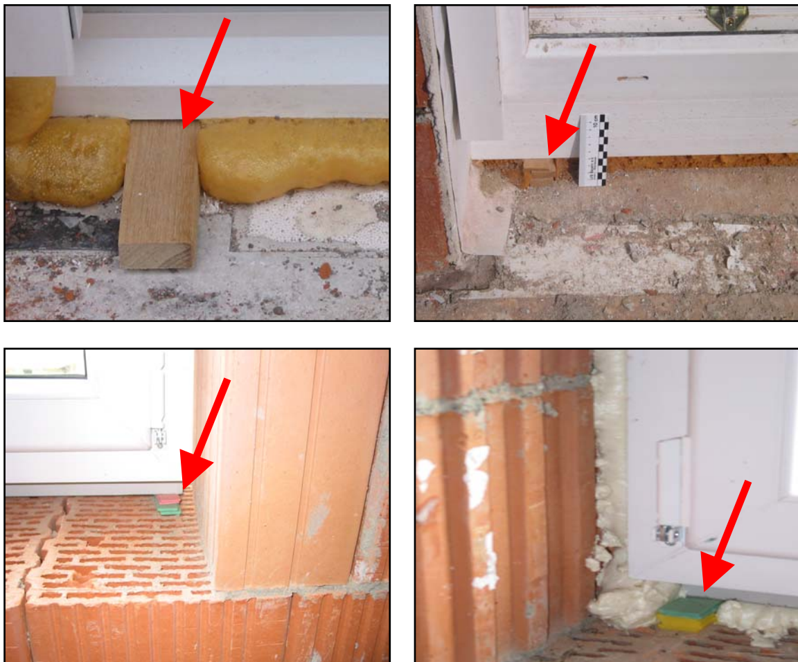
Abbildung 2: In der Praxis häufig vorzufindende mangelhaften Tragklotzungen.
