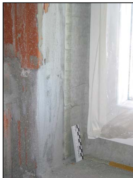
Abbildung 14 : Beispielhaft dargestellte fachgerechte Fugenabdichtungen.
