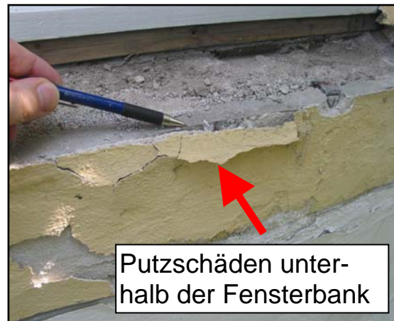
Abbildung 10: Ansicht der Brüstung nach Rückbau der Fensterbank.
